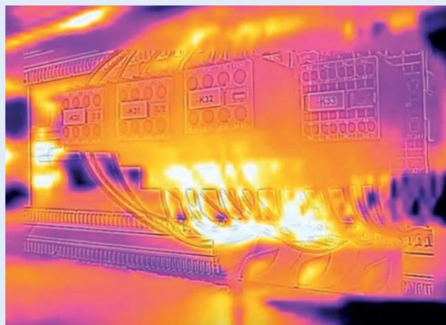
Image thermique d'un point chaud dans l'armoire de commande
