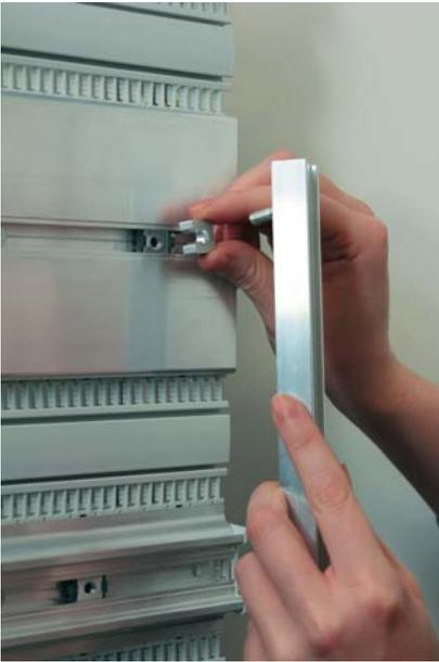
Variante 1 : pour les nouvelles constructions de traverses à rail Oméga (type HS / HA) sur des traverses de montage (type MS / MA) il est possible d'utiliser des supports CST 7 pour ajuster la hauteur.
