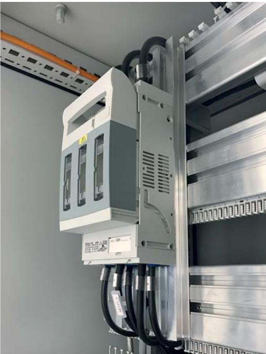
Fig. 1 : interrupteur principal sur RG 035.
