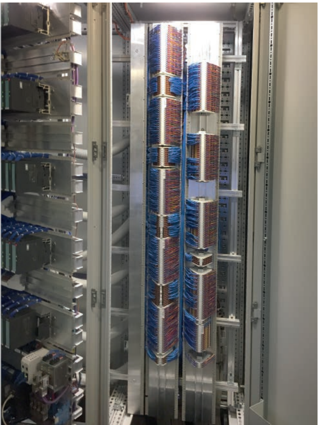
Beispiel eines überarbeiteten Schaltschranks mit dem LSC-System als Einschubvariante mit vertikalem Klemmenaufbau. Quasi zwei Verdrahtungsebenen in einem Schrank (Abb.:LÜTZE)
