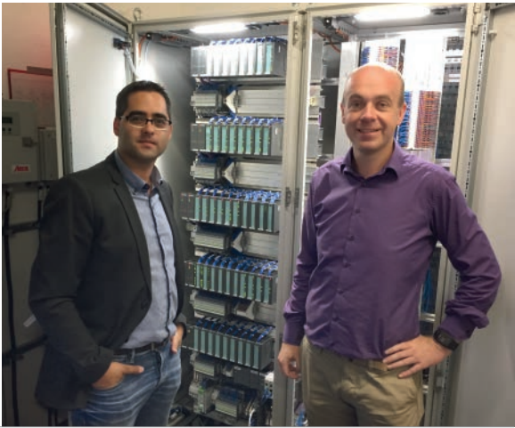
Wolfgang Krause von der AWG Abfallwirtschaftsgesellschaft mbH Wuppertal (rechts) und Jose Antonio Ruiz Simon (links) von der a+h Vertriebsgesellschaft mbH, einem Partner / Distributor von LÜTZE. Begutachtet wird ein mit LÜTZE LSC aufgebauter Schaltschrank (Abb.: LÜTZE)
