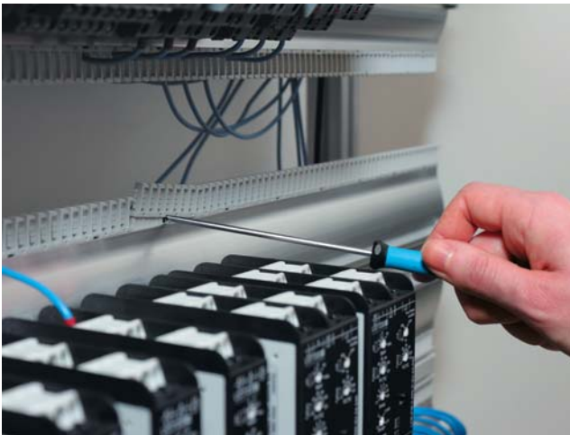
Schritt 1: Lösen der Kämme mit einem Schraubenzieher
