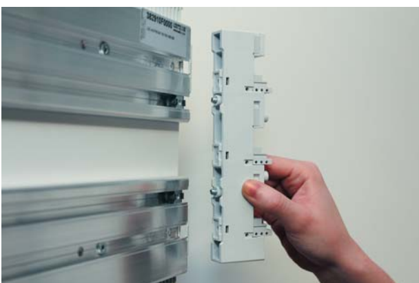
Schritt 3: Wenn beide Gleitmuttern an der gewünschten Stelle platziert wurden, kann die Komponente dort angebracht werden.
