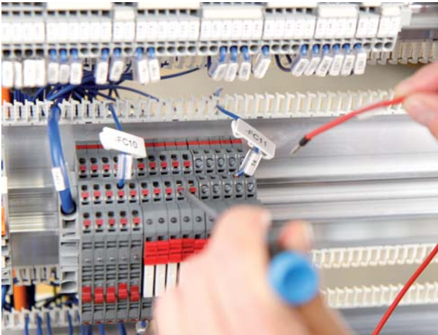
Schritt 1: Anschließen der Ader an der Komponente
