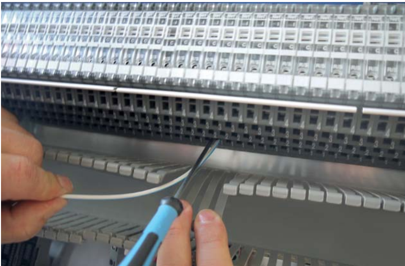
Im Vergleich: Montageplatte - Behinderung durch Kabelkanal
